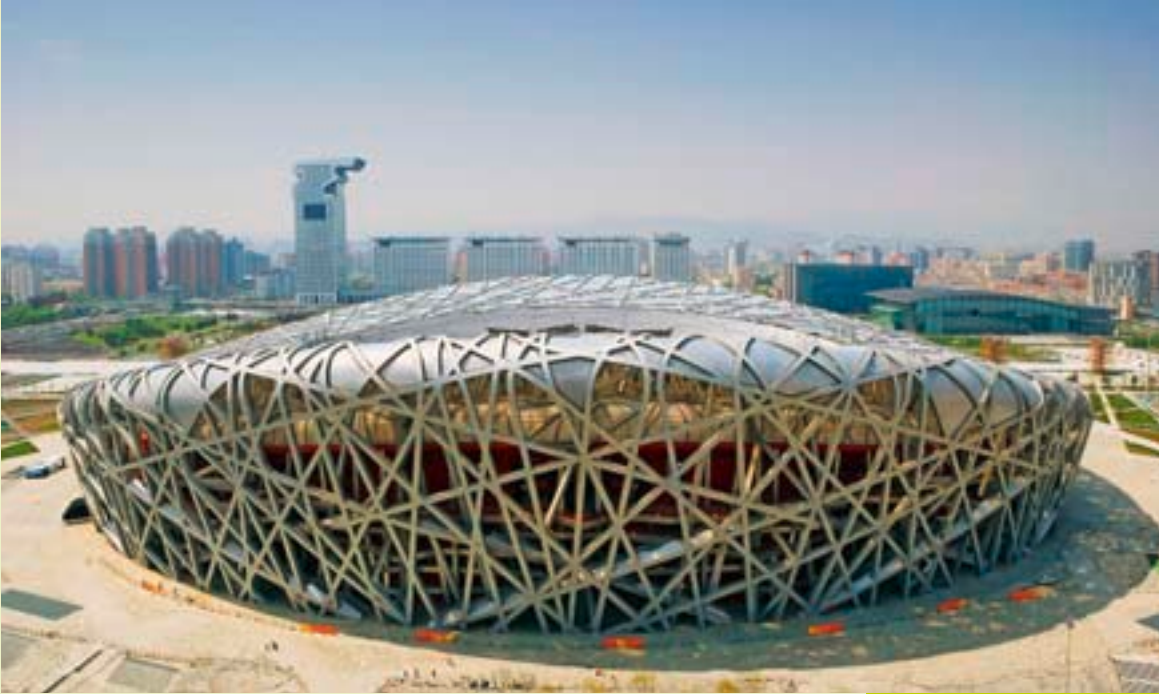
Das Olympia-Stadion in Peking hat den Spitznamen Vogelneest. Die verwobene Stahlkonstruktion macht sich Formen der Natur zunutze
