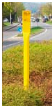
Die gelben Sichtpfähle zeigen an, wo eine Erdgasleitung liegt.
