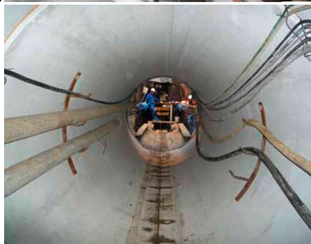
Der unterirdische Rohrvortrieb für die Fahrrohrleitungen vermeidet, dass oberirdisch tiefe lange Gräben gezogen werden
